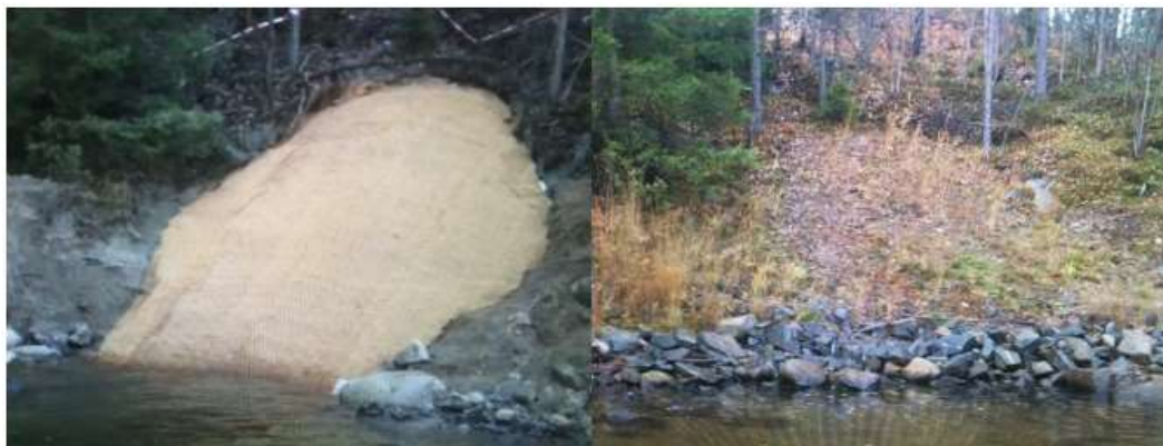
Figur 5. Betongmadrass beklädd med kokosmatta. I högra bilden är kokosmattan bevoxen.
