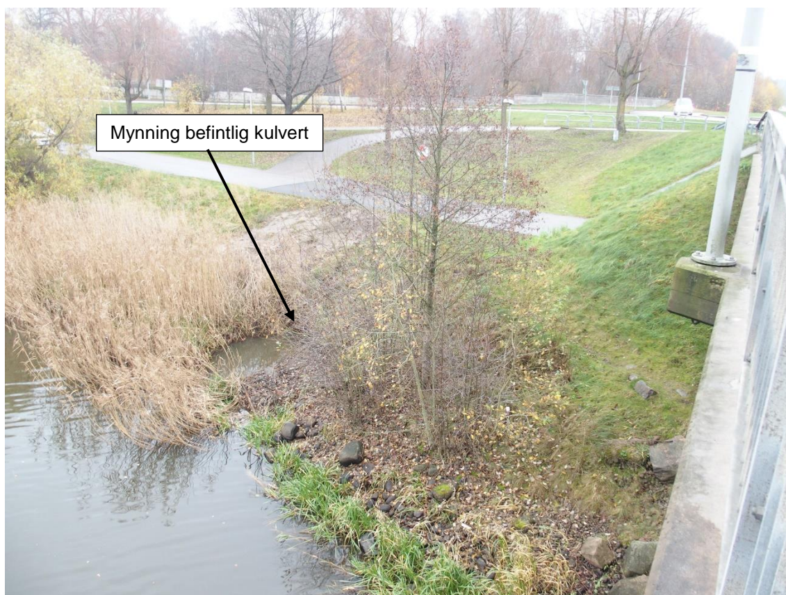
Figur 5. Befintlig kulvert mynnar i anslutning till Ågårdsbron. Foto Lidköpings kommun.
